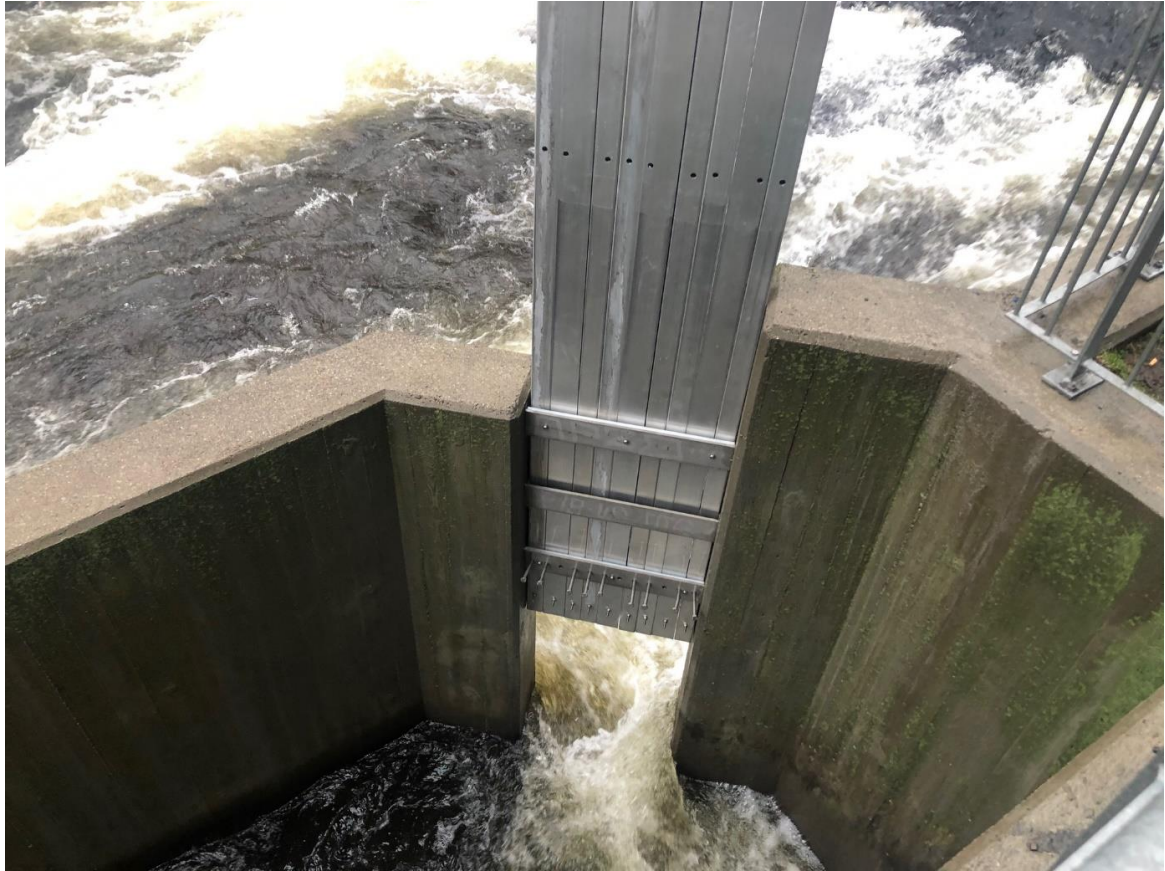
Figur 6. Eksempel på manøvrerbart flomløp i tilknytning til Akerselva, Oslo (Foto T. Mæhlum)
