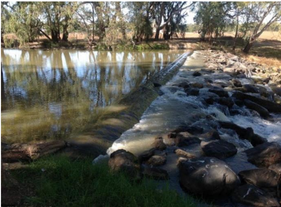
Figur 5. Bilde av terskeldam med flatt overløp og plastring med grov stein
