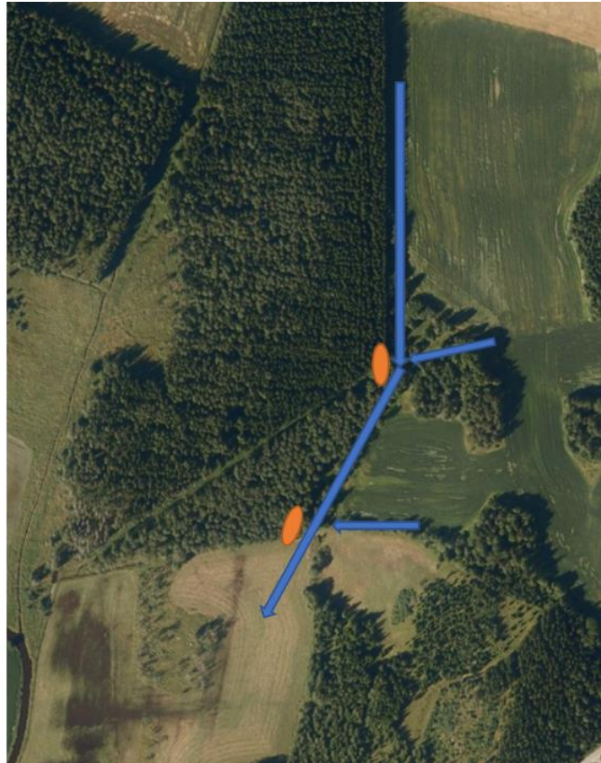
Figur 11. Rehabiliteret grøft for oppsamling av vann fra områder nord for Kjelle
