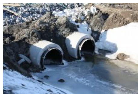
Figur 2. Tilbakeslagsventil montert i rør på utløpsiden. Type WaStop levert av MFT. Foto: MFT.
