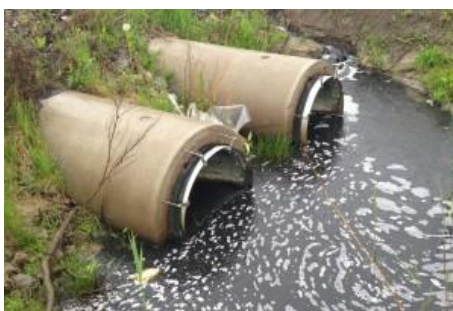
Figur 2. Tilbakeslagsventil montert i rør på utløpsiden. Type WaStop levert av MFT. Foto: MFT.
