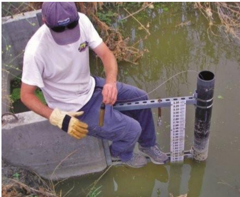
Figur 3.1: Enkel vannmålestasjon med målestav og perforert rør for vannstandsloggeren (trykksensor). Foto: CIK Solutions (2023).
